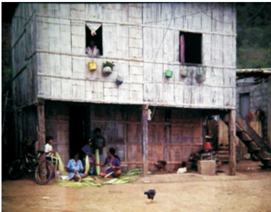
■ Vivienda tropical que se observa la falta de protección.
